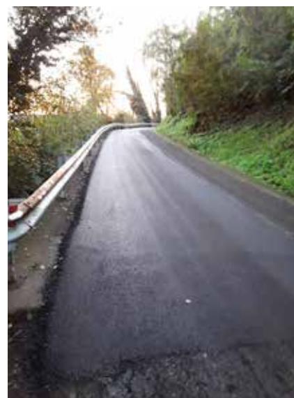
L'asfaltatura in via Costalta
